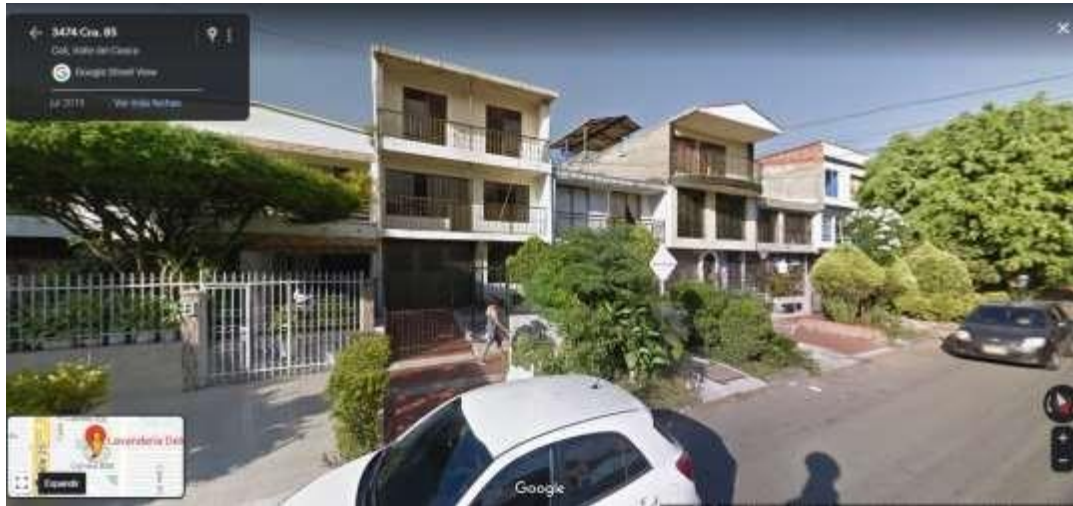
VISTA DE LA FACHADA
